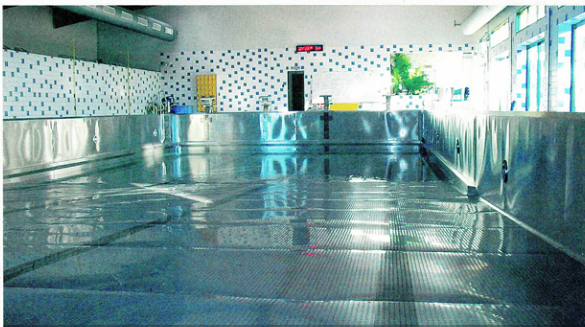
Tous les éléments du bassin intercommunal sont en inox : le fond, les murs, les échelles, la visserie et le plongeur.
